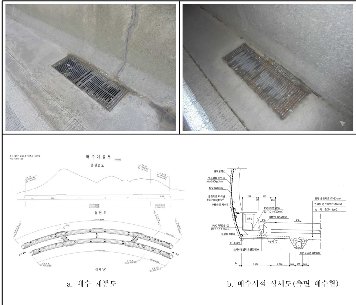
【사진 5.3.12】 배수시설 전경
