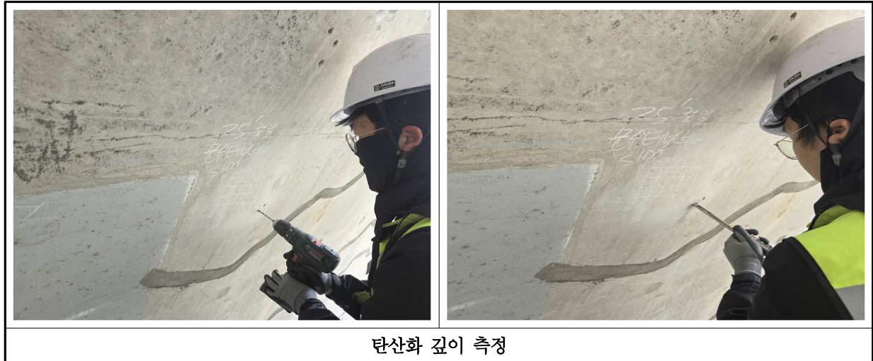
【사진 5.4.2】 탄산화 깊이 시험 현장사진
