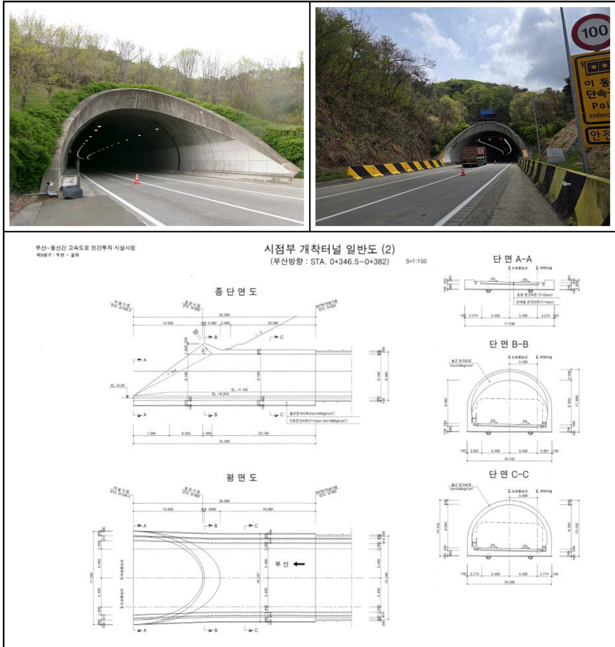
【사진 5.3.5】 갱문 전경
