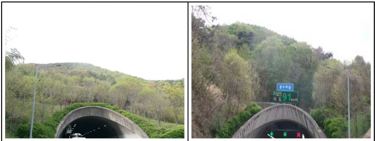
【사진 5.3.8】 사면 전경
