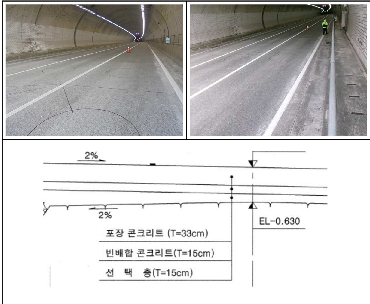
【사진 5.3.14】 포장부 전경
