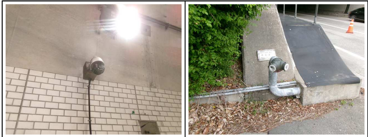
【사진 5.3.16】 기타부속시설 전경
